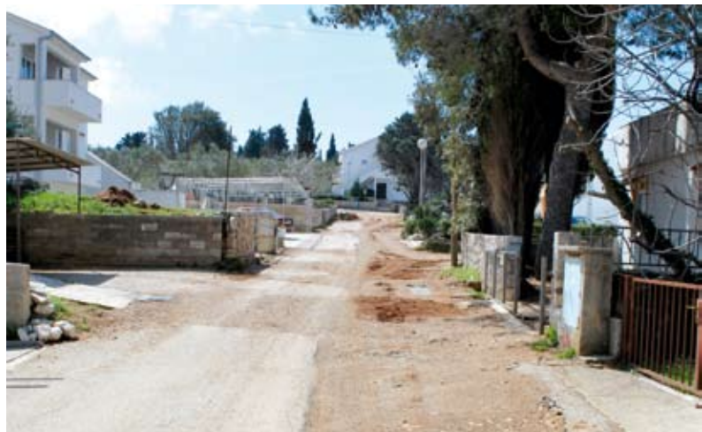
Novi vodovod, fekalna i oborinska kanalizacija: Odvojak A. Cesarca, Dio ulice Nikola Tesla
